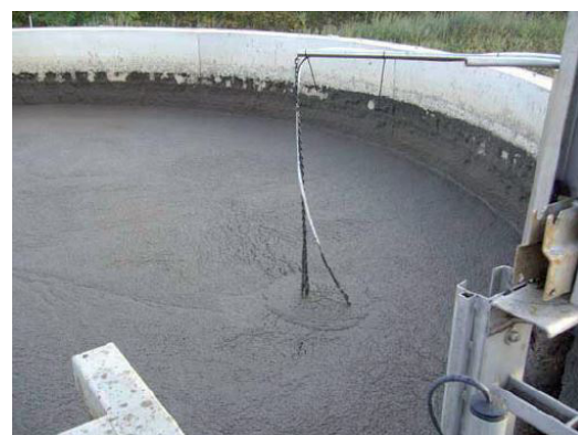
Abb. 1: Einsatzort der VARiON ® -Sonde im SB-Reaktor auf der Kläranlage in Hanau
