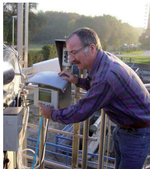
Abb. 2: Herr Faust von der KA Hanau bei der Arbeit an einem IQ SENSOR NET-System mit der beschriebenen VARiON ® -Sonde
